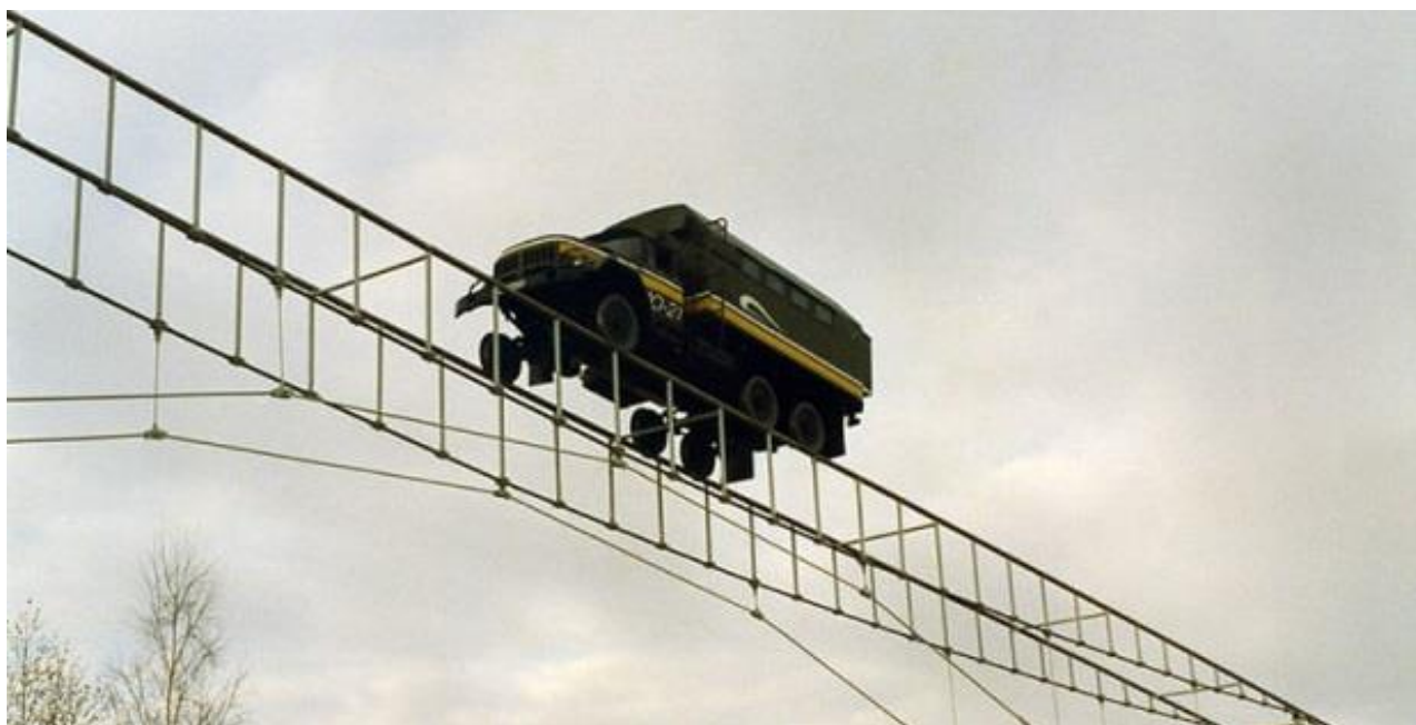
Рис. 11. Вид эстакады на основе «изобретения» А.Э. Юницкого Испытательный полигон в городе Озёры. Источник: https://unitsky.engineer/projects/polygon
